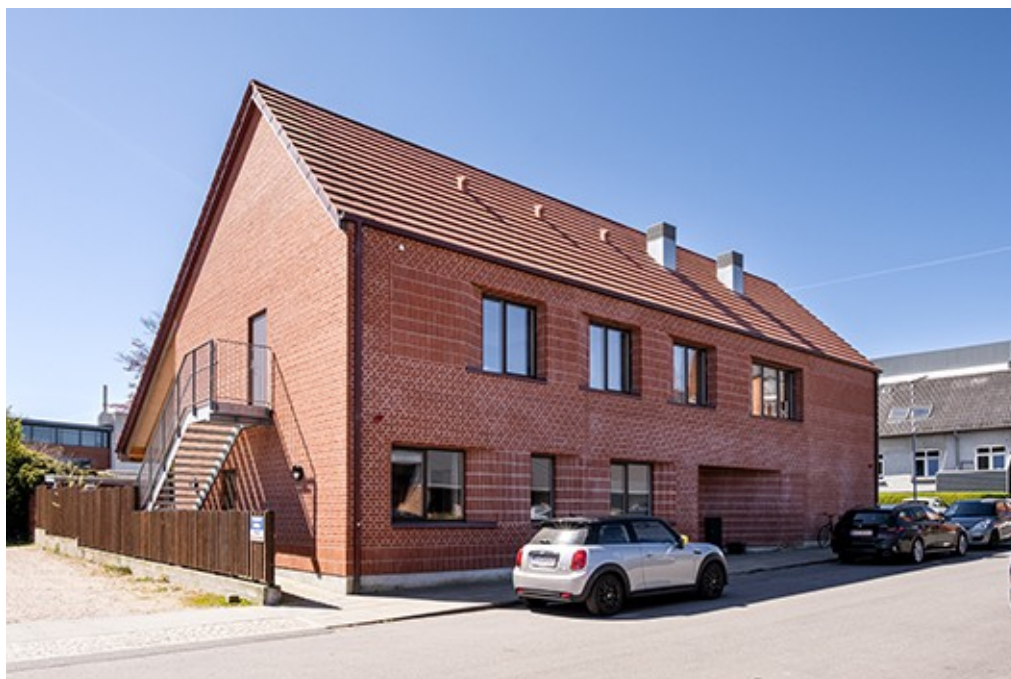
Det nye værested i Esbjerg, facaden. Foto: ZENI arkitekter.
