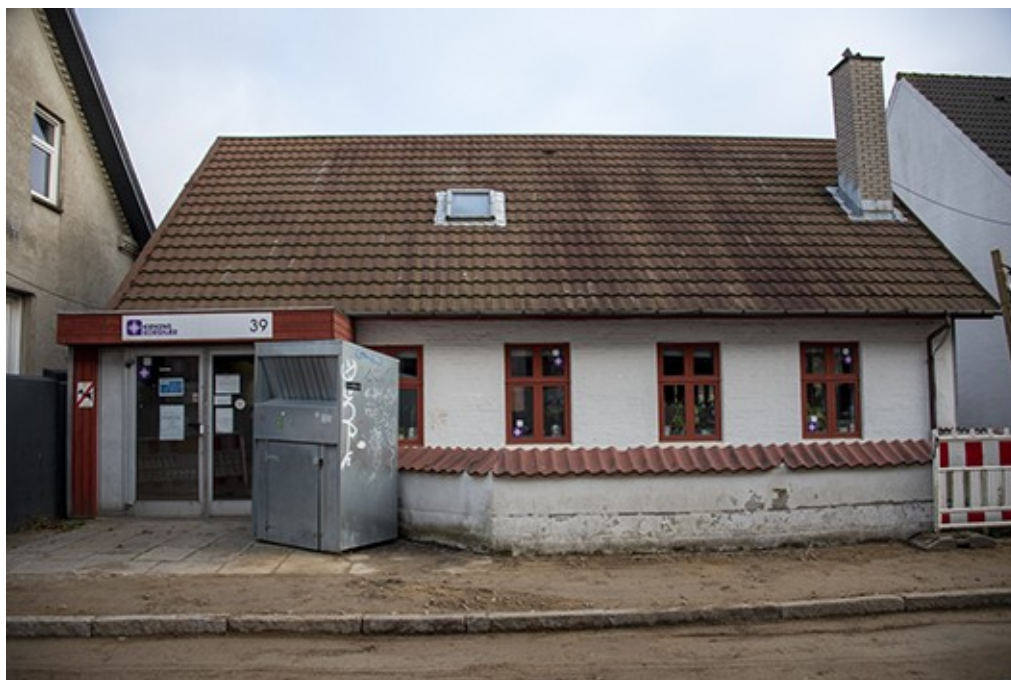
Det gamle værested i Esbjerg, facaden. Foto: Carlberg.
