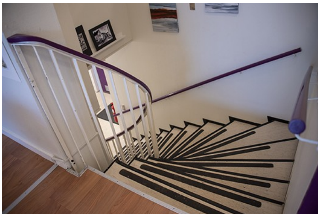
Værestedet i Nykøbing F, trappe til kælderen med værestedets eneste toilet før ombygningen. Foto: Carlberg.
